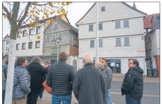
Die Stadt Borken will in der Bahnhofstraße selbst aktiv werden und zwei leerstehende und stark sanierungsbedürftige Gebäude zunächst erwerben, dann rückbauen und die Fläche für einen privaten Investor aufbereiten.
